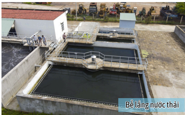
Bể xử lý nước thải
