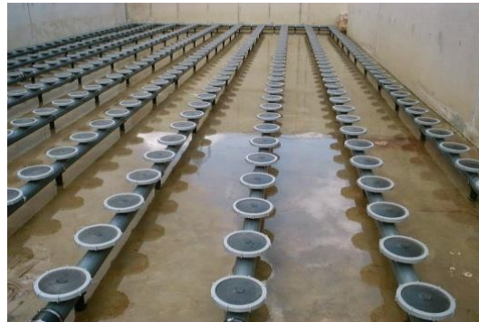
Hình 3.11. Bể Aerotank và đĩa phân phối khí
