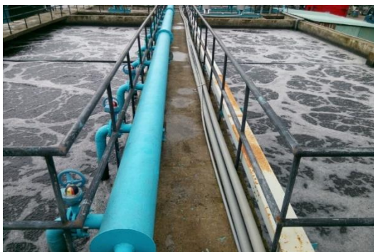
Hình 3.11. Bể Aerotank và đĩa phân phối khí
