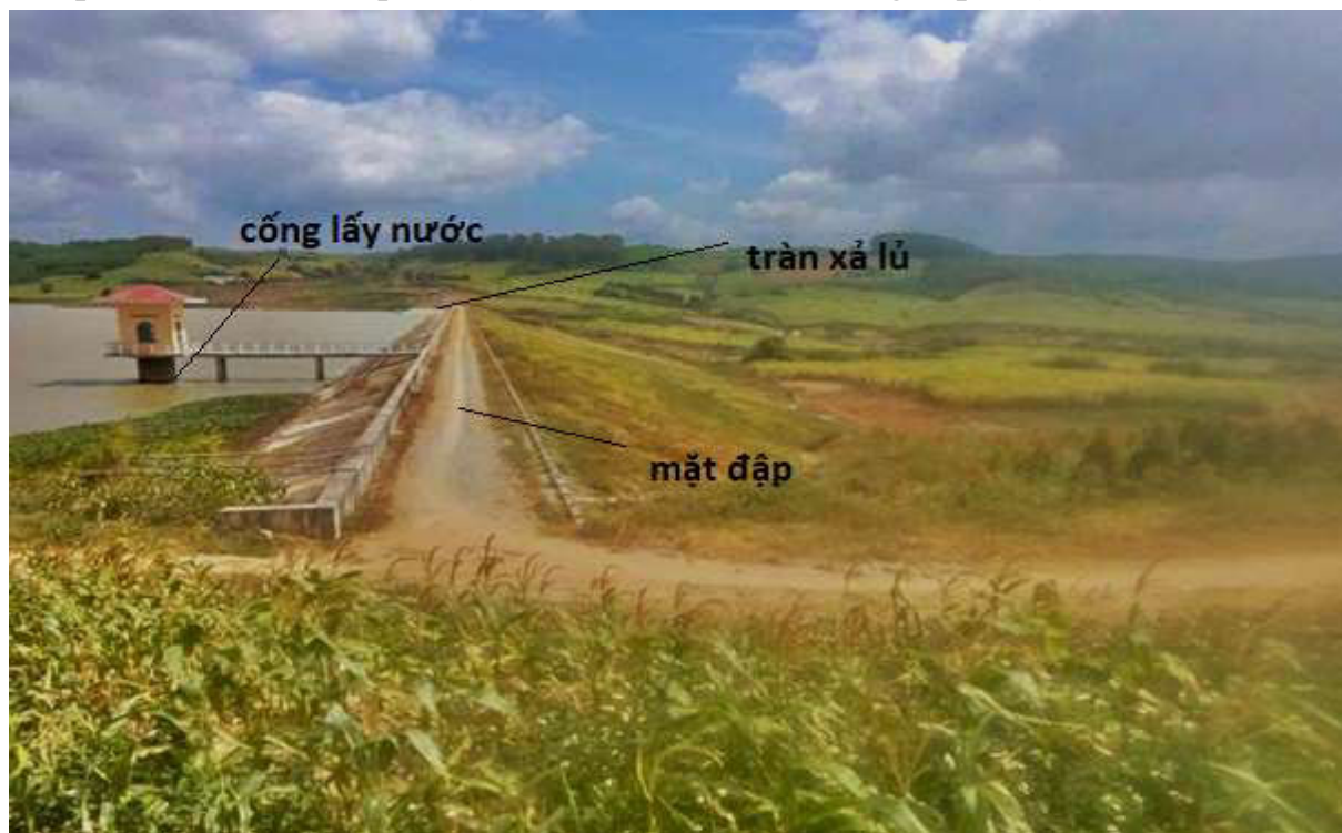
Hình 2: Hình ảnh các hạng mục tại công trình đầu mối – Công trình thủy lợi Tàu Dầu 2
