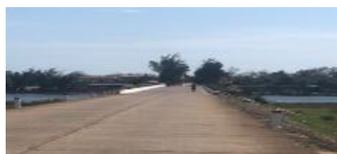
Sông Hà Ra nơi sẽ xây dựng một cây cầu mới bên cạnh cây cầu hiện tại
